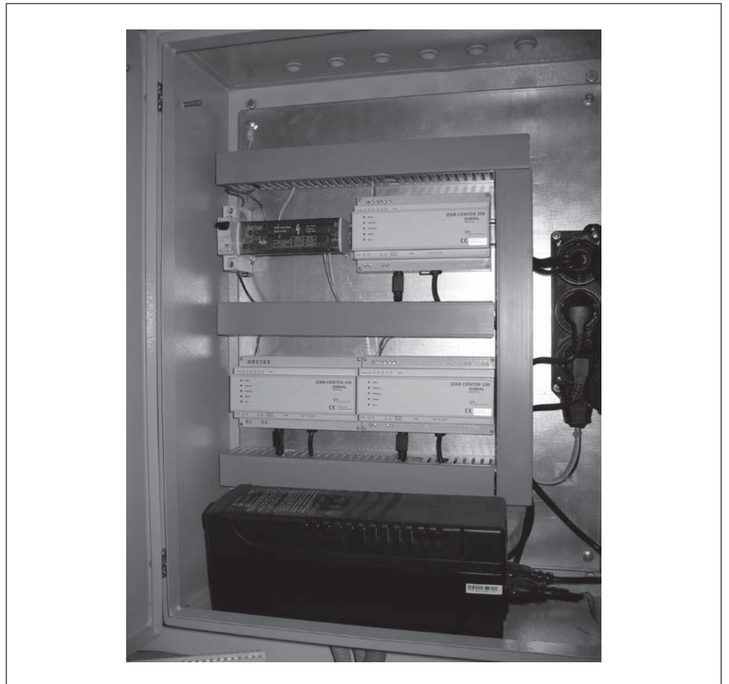
Пример монтажа концентраторов Izar Center
