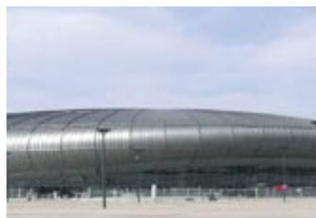
На крупных объектах Тепловых Сетей г. Будапешт (Венгрия), установлены шаровые краны типа JIP Ду200 - 400 с ручными редукторными и электрическими приводами.
